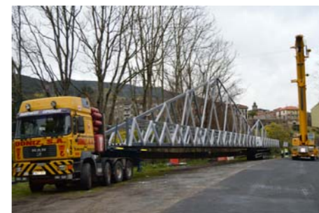
proceso de montaje
