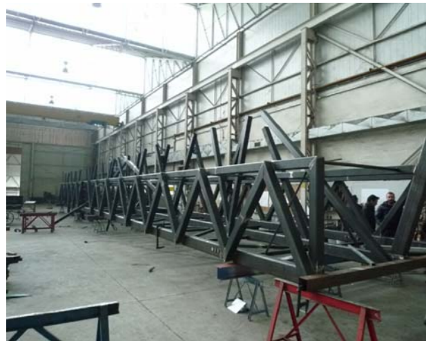
ejecución en taller
