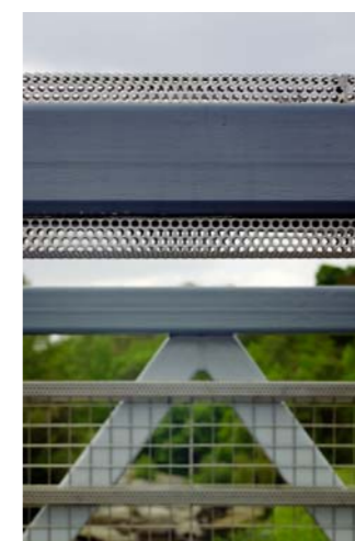
detalle de luminarias
