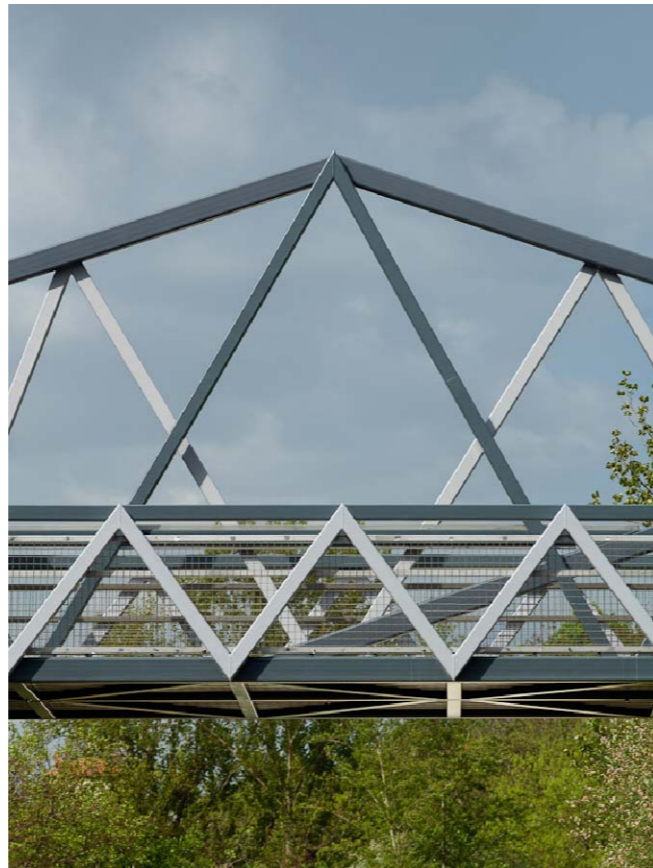
detalle de estructura
