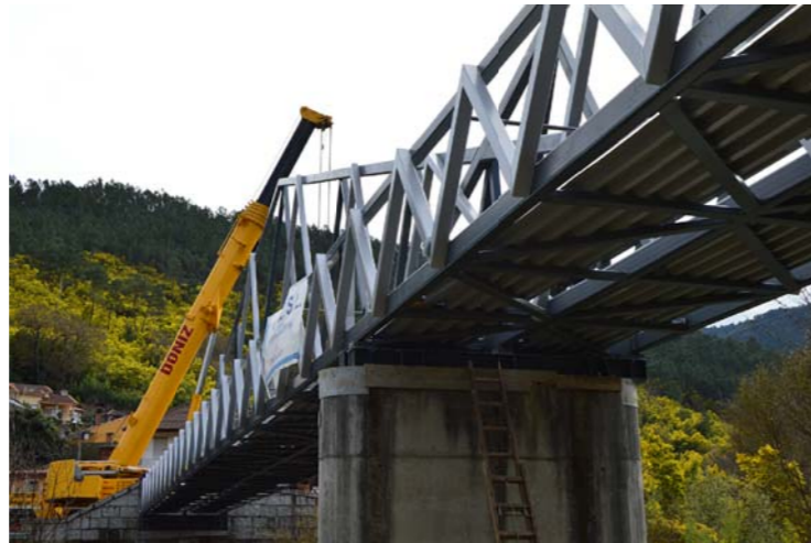
proceso de montaje
