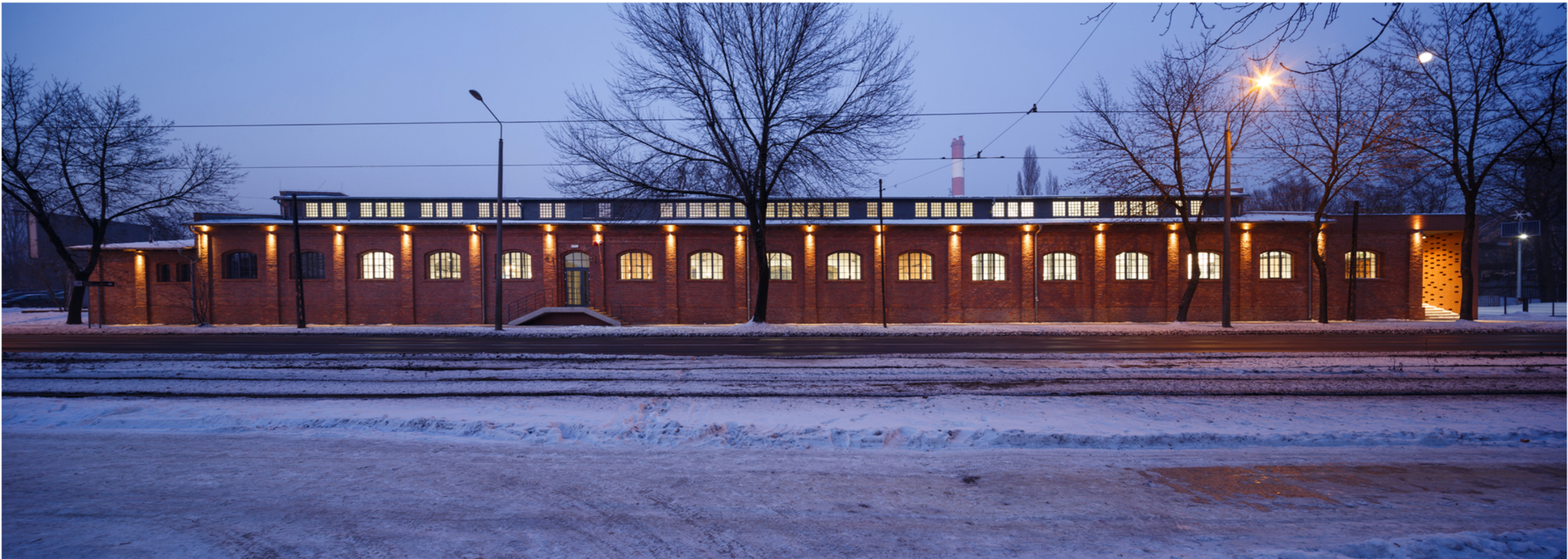
SITE AFTER REVITALISATION
