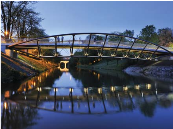
Nouvelle passerelle sur le canal Gruber, Dans arhitekti, Ljubljana, 2010 © KID
